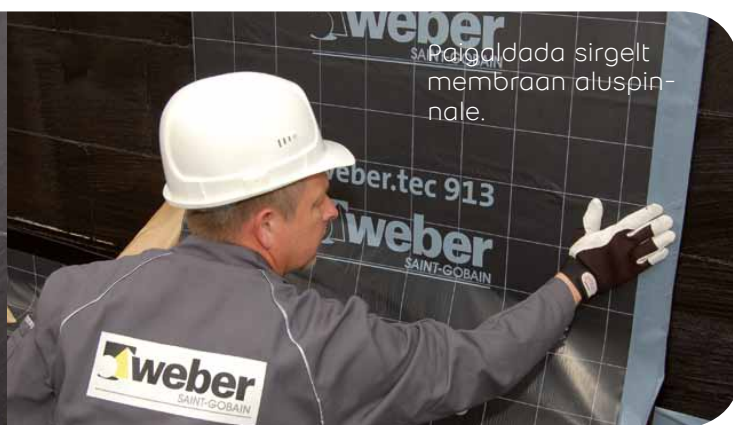
Eemaldada rulliga ka membraani alla äänud õhumullid.
