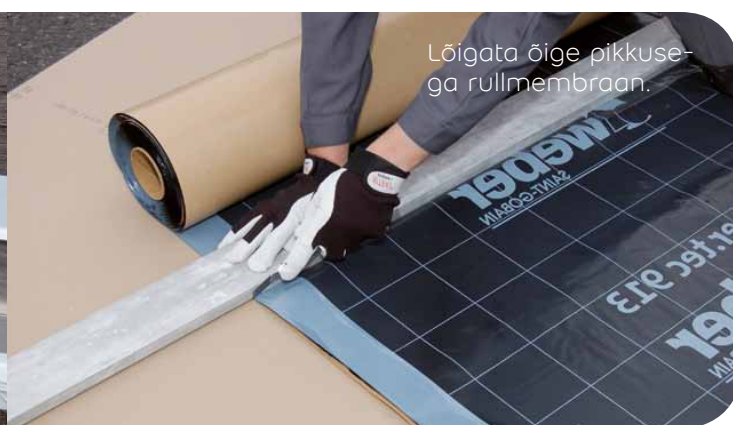
Palgaldada sirgelt membraan aluspinnale.
