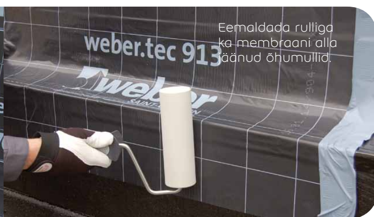
Kasutada rulli membraani aluspinnale kinnitamiseks.
