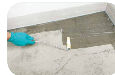
Kanna pinnale epoksüüd nakkekrunt
