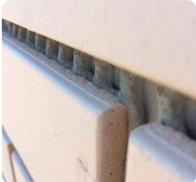
Välja pressiva liimsegu järgi on näha, et liimsegu nakkepind on 100%
